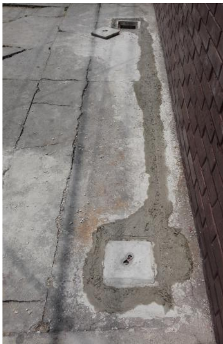
Trabajo exterior (cajas de registro)
